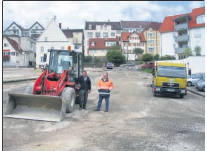
Zum Hechingen aktiv-Wochenende fertig: Ausbauarbeiten am Firstparkplatz
