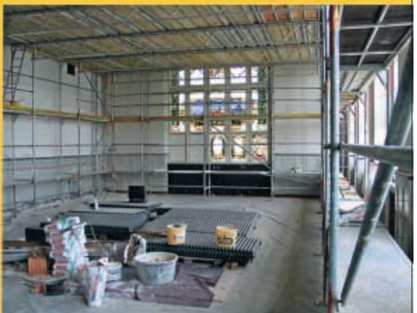
Aula Gymnasium: Zum Festakt "100 Jahre Gymnasium" am 24.7.2009 wird die Aula in neuem Glanz erstrahlen. Kosten: 50.000 €.
